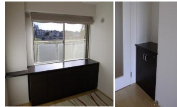
腰窓下(左)とニッチスペース(右)を利用し地袋収納を設置。
