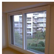
北側のサッシは内窓を取付、2重窓に。
