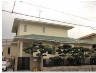
屋根・外壁も新築のように。
