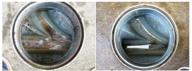
管内だけでなく排水枡の内部等も綺麗に...(右が洗浄後)
